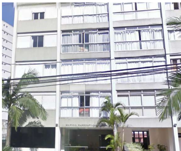
Figura 2: Edifício Farroupilha, na Vila Mariana
