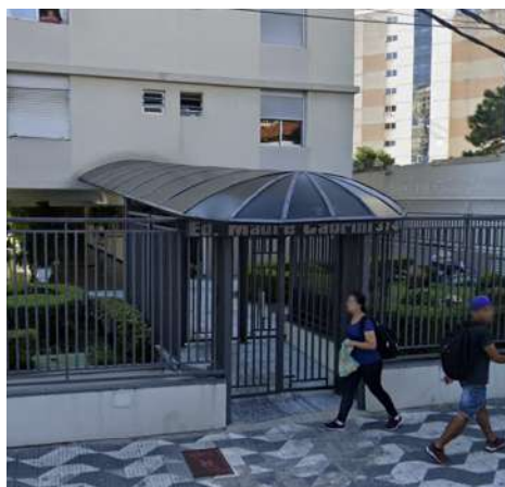
Figura 3: Edifício Madre Cabrini, na Vila Mariana
