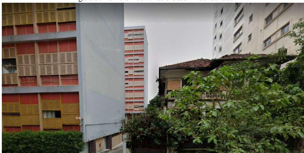
Figura 3: Edifício Louveiras e Casa “Abandonada”
