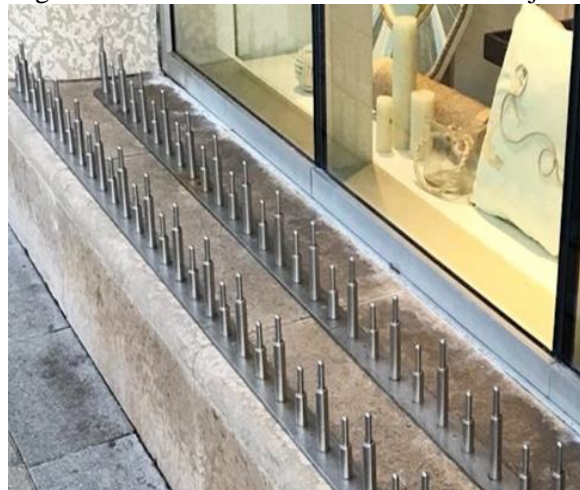
Figura 4 – Pinos metálicos em fachada de loja
