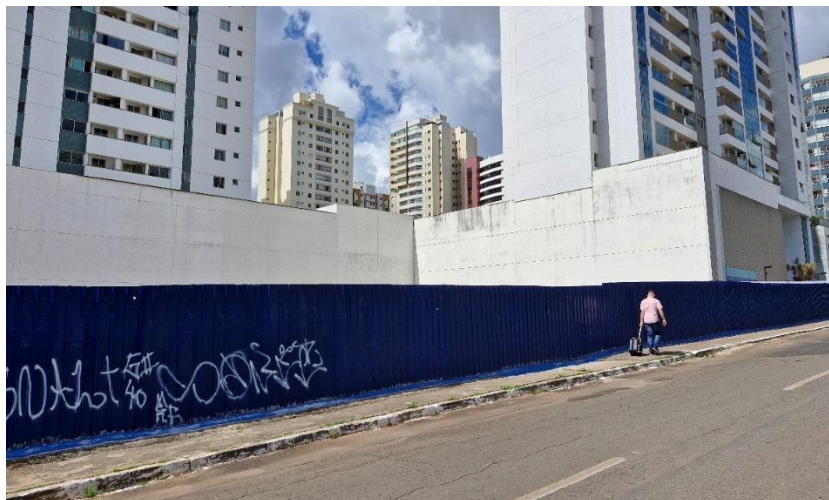
Figura 2: Figura 27: Homem caminha ao lado de lote vazio rodeado por muros (R. 34 Sul). O lote em questão (6) é um terreno abandonado cujos tapumes foram substituídos recentemente. O terreno também foi limpo e sua grama podada. Fonte: arquivo pessoal do autor.
