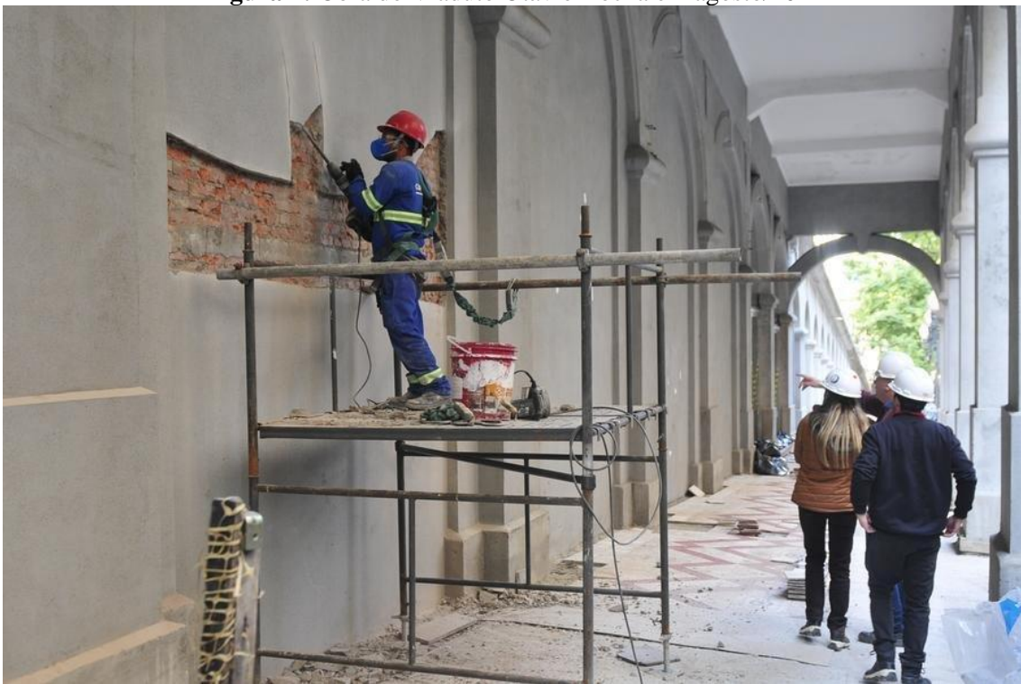
Figura 2: Obra do Viaduto Otávio Rocha em agosto/2024
