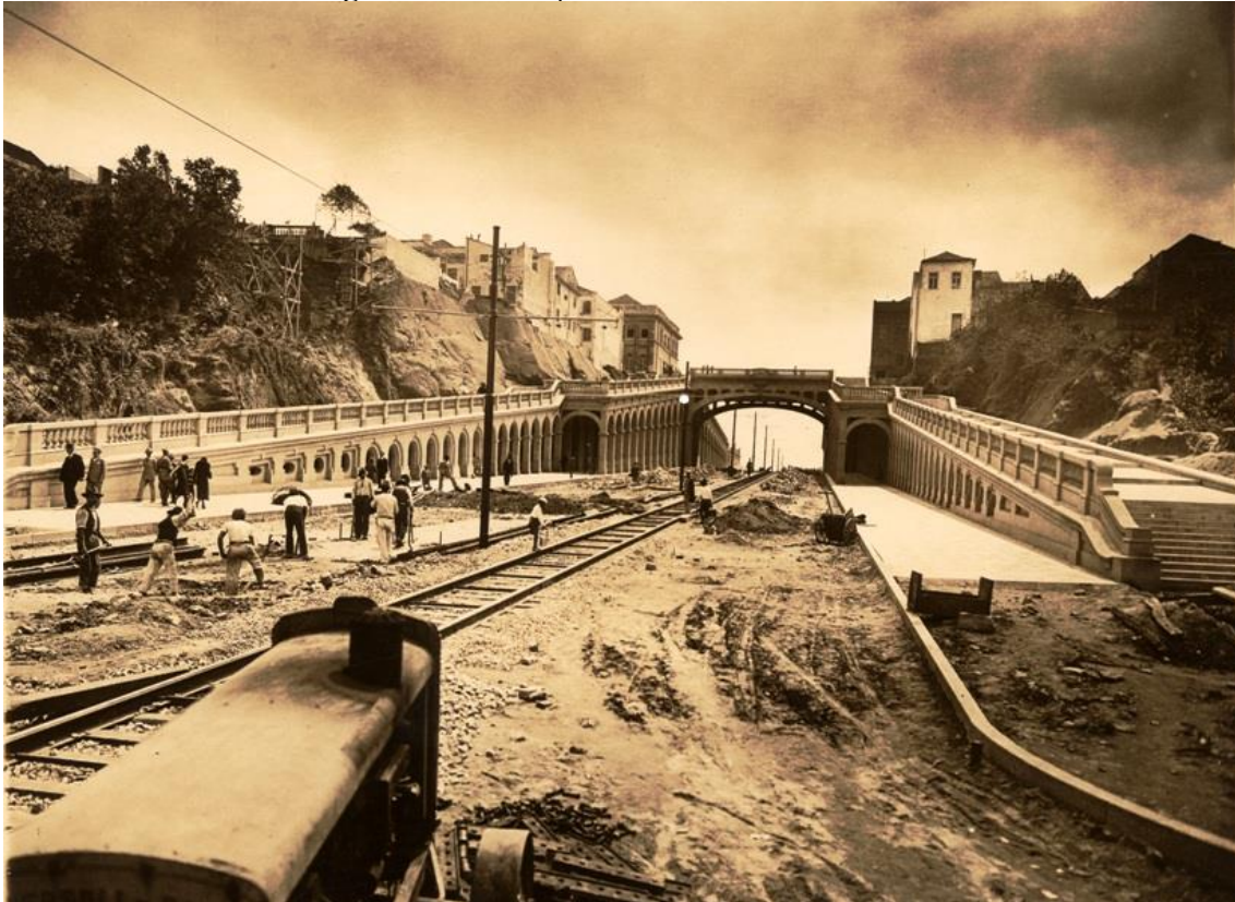
Figura 1: Construção do Viaduto Otávio Rocha
