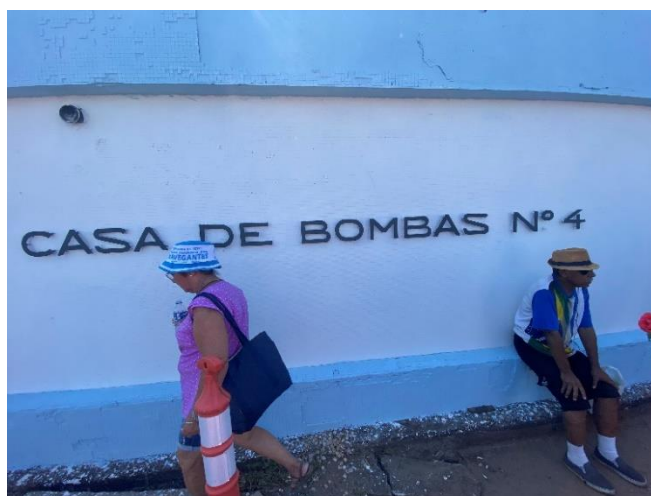
Figura 4 – Casa de bombas
